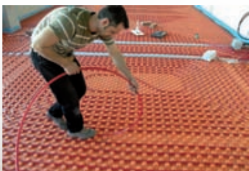
Детали монтажа системы тёплого пола IVR
