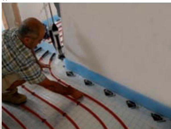
Детали монтажа системы тёплого пола IVR
