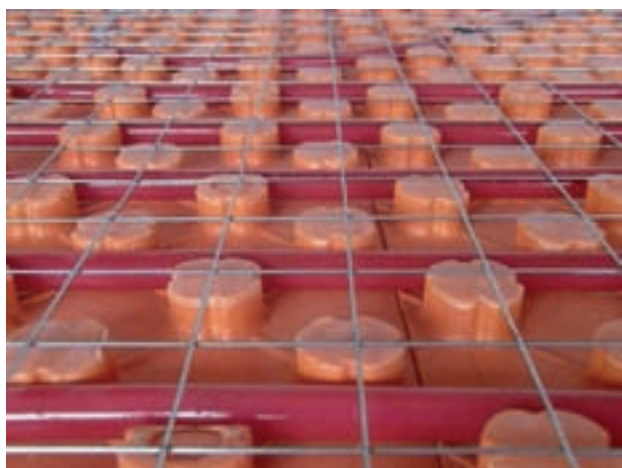
Применение электросварной сетки IVR
