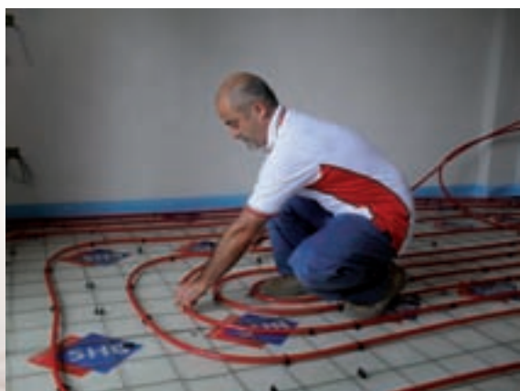
Детали монтажа системы тёплого пола IVR
