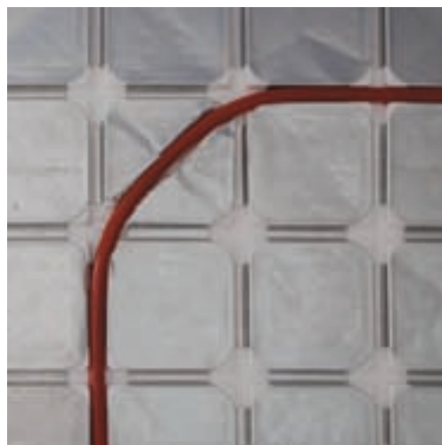
Панель с разрезанной фольгой и проложенной по диагонали трубой
